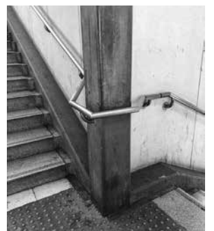
籠原駅南口の階段の手すり
