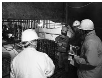
耐震化改修工事の視察中
