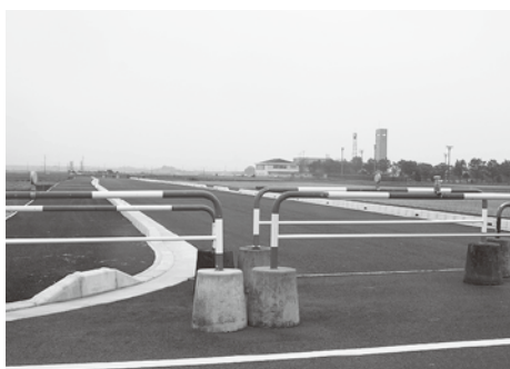
整備を完了した区間
