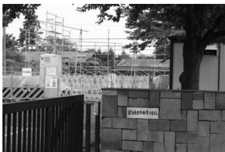
大麻生小学校内に建設中の「第2大麻生児童クラブ」
