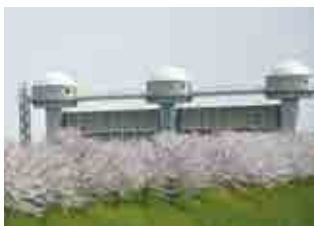
和田吉野川下流部にある玉作水門
