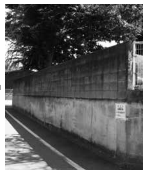
三尻小学校改修前
