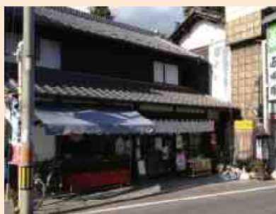
県の「経営革新計画承認制度」を活用し、建物を覆っていたパラペットを外すなど昔の外観復元を重視したお茶屋さんのリニューアル
