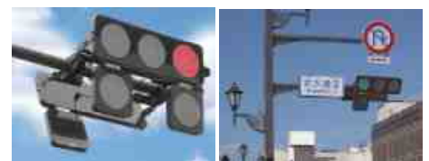
フラットタイプの車両信号。ひさしが不要であり、陽光の映り込みによる見えにくさもない。
