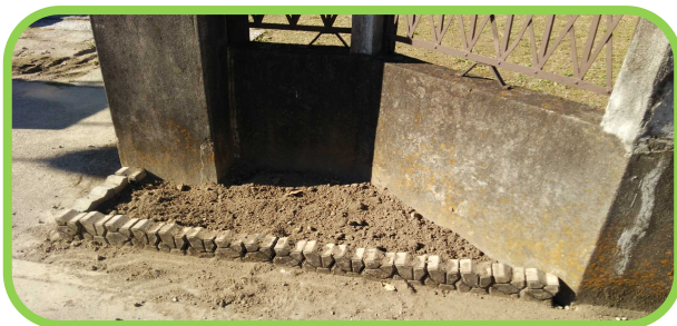
土留めにインターロッキングブロックを活用
