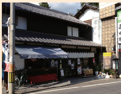
県の「経営革新計画承認制度」を活用し、建物を覆っていたパラペットを外すなど昔の外観復元を重視したお茶屋さんのリニューアル
