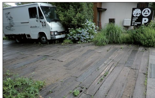
枕木をラフに敷き詰め、隙間に植栽を施しただけでおしゃれなテラスのように。（他都市）
