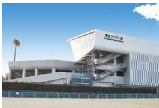
改修工事中の熊谷ラグビー場
