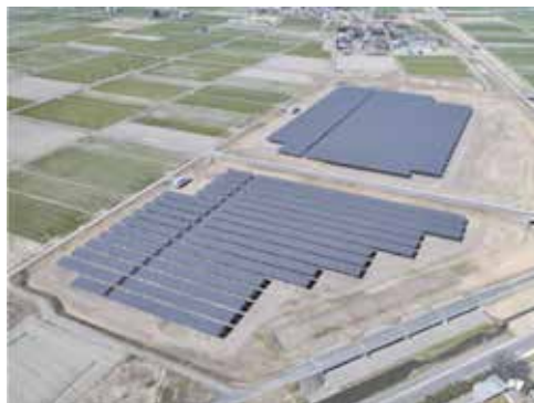
調節池を利用したメガソーラー
