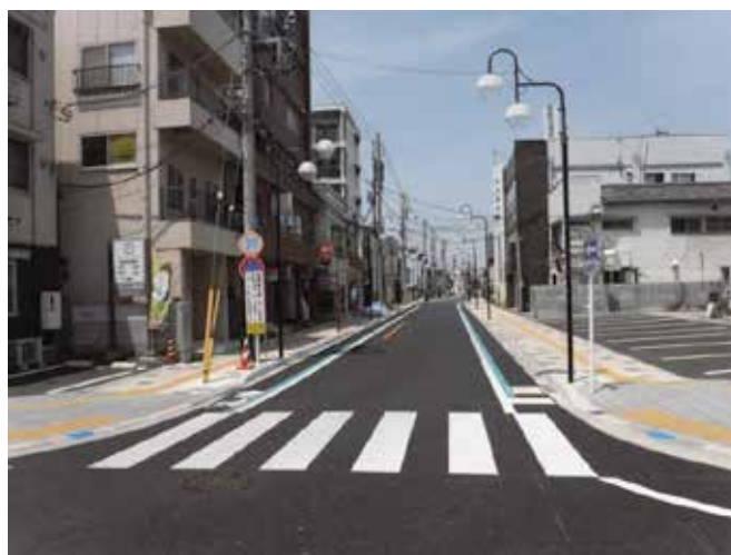
市道 80034 号線 (弥生町)
