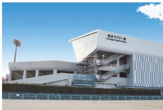
改修工事中の熊谷ラグビー場
