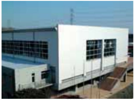
江南中学校体育館
