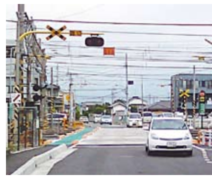
8月に工事が完了した新寄居踏切
