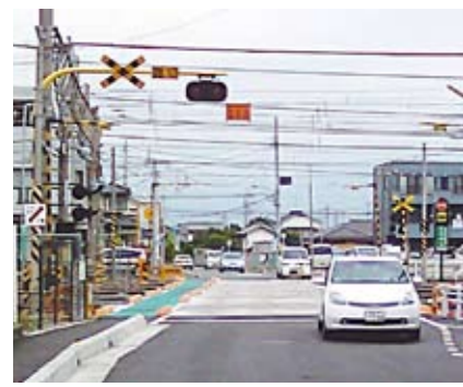
8月に工事が完了した新寄居踏切
