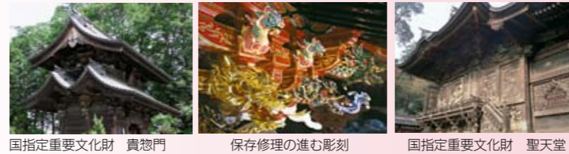
国指定重要文化財 貴惣門 保存修理の進む彫刻 国指定重要文化財 聖天堂
