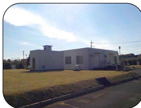
吉岡配水場 施設能力 3,680m 3 /日
