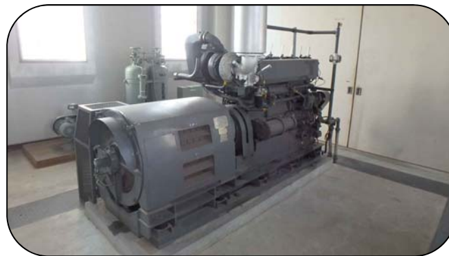
図 3-4.自家発電設備（1976 年製）
