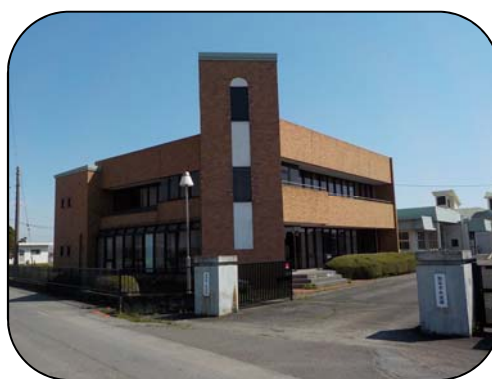
妻沼第1浄水場 施設能力 3,000m 3 /日
