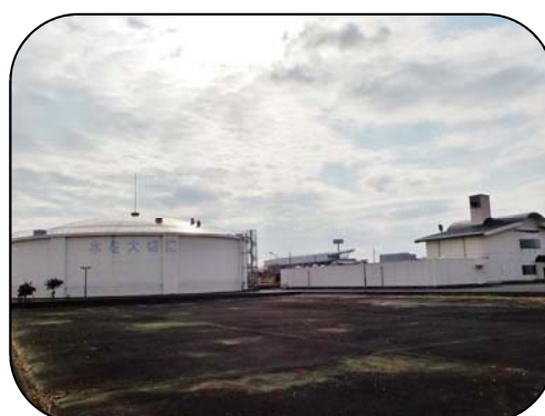
北部配水場 施設能力 10,810m 3 /日
