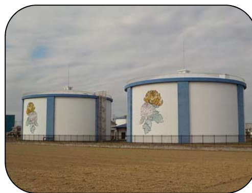
妻沼新第2浄水場 施設能力 15,800m 3 /日
