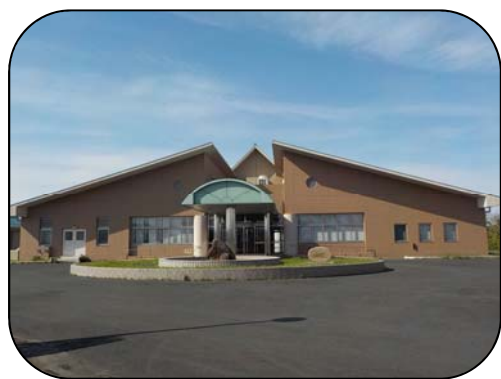
玉作浄水場 施設能力 2,600m 3 /日
