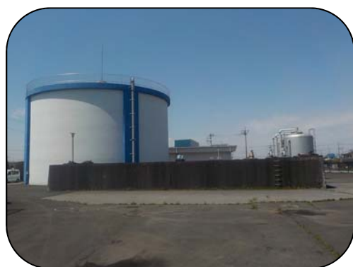
妻沼第2浄水場 施設能力 5,960m 3 /日
