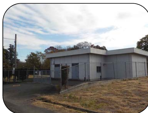
塩増圧配水場 施設能力 890m 3 /日
