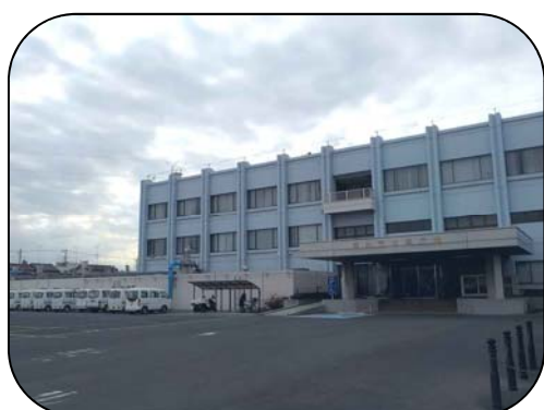
東部浄水場 施設能力 50,000m 3 /日
