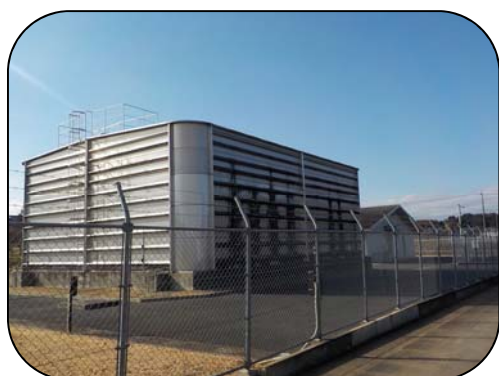
小江川増圧配水場 施設能力 1,356m 3 /日
