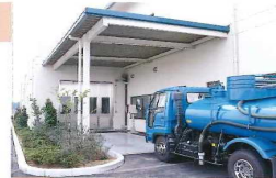
トラックスケール 集められてきたし尿や浄化槽汚泥を計量し、計量データはコンピュータにより集計されます。
