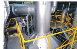
焼却炉 脱水汚泥やし渣を焼却します。汚泥の一部は乾燥汚泥としてコンポスト設備へ送ります。
