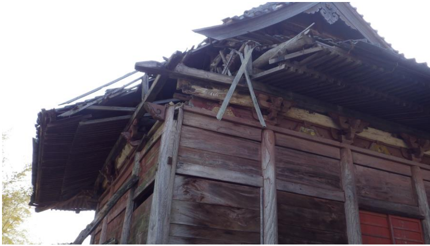
修理前の損傷が激しかった北西隅
