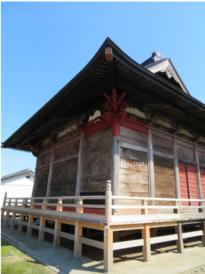
保存修理後の北西隅の状況
