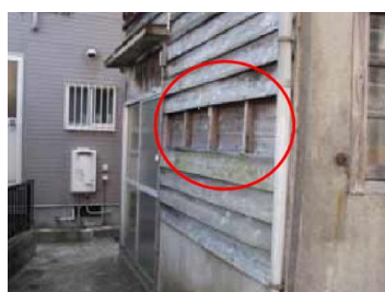
②外壁の仕上材の一部がはがれ、下地が露出している例
