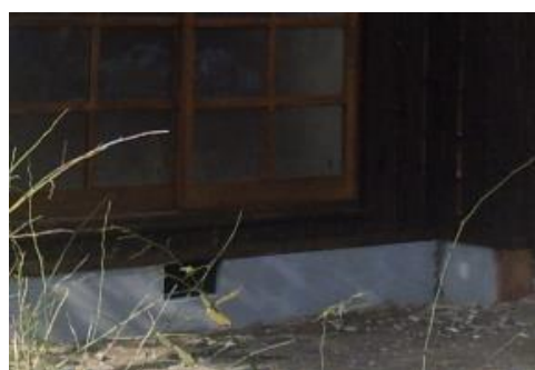
コンクリート基礎等（評点 0）
