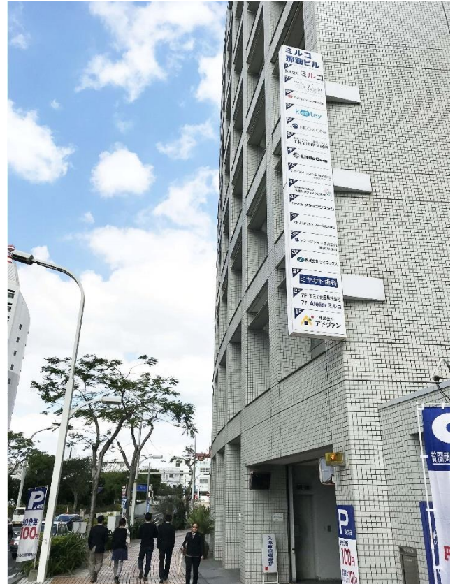
縦方向の長さを抑え、建物の低層部に揃えることで、すっきりした印象を与えます
