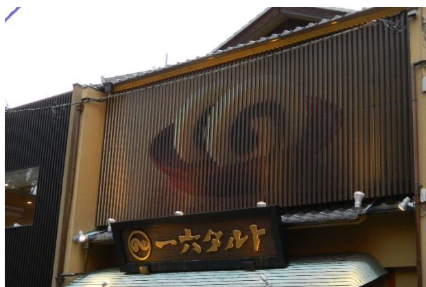
ルーバーの角度によって見え方に変化を付けることで、周囲に配慮しつつ、効果的な広告物とすることができます
