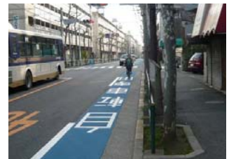
自転車専用通行帯による分離 （東京都渋谷区）
