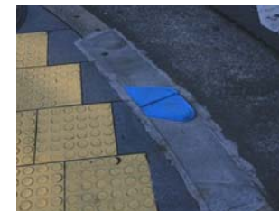
進行方向にまっすぐ設置された UDブロック
