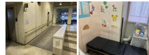
勾配のきついスロープ
