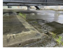
屋上(目地の劣化)
