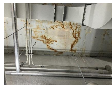
機械設備(ポンプのさび)
