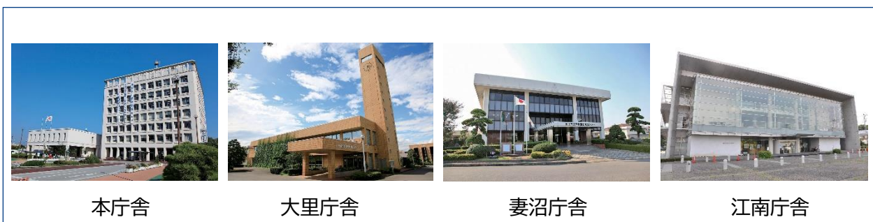
本庁舎・分庁舎の現況
