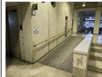
勾配のきついスロープ
