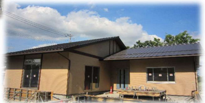
現在建設中の佐谷田会館
