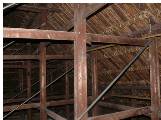
茅葺屋根下の梁状況
