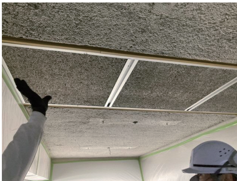
アスベスト除去の立入検査の様子
