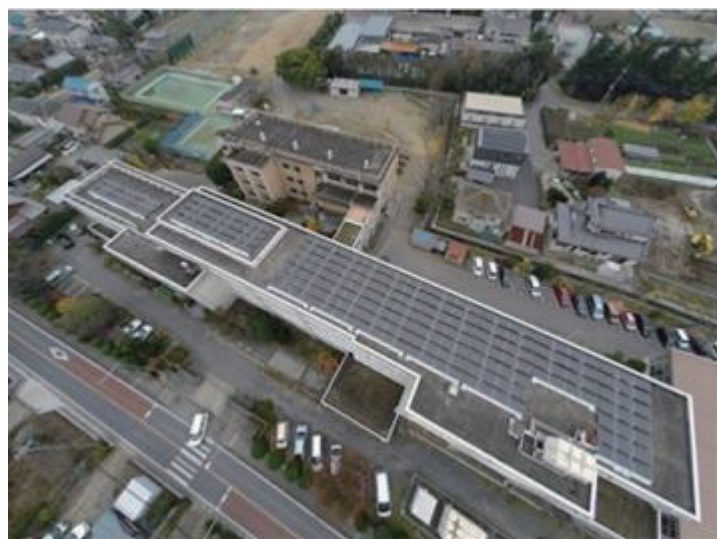
熊谷市市有施設屋根貸し太陽光発電事業
