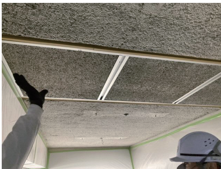
アスベスト除去の立入検査の様子
