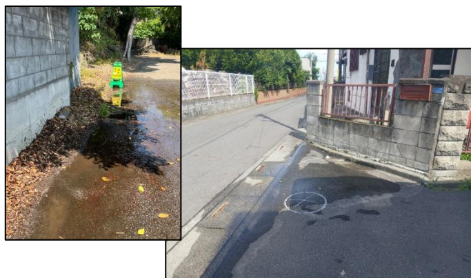
市内で発生した漏水
