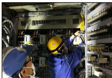
設備の点検・修繕
