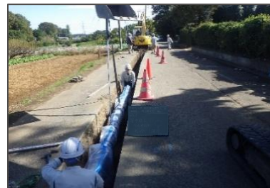
配水管の更新・耐震化
