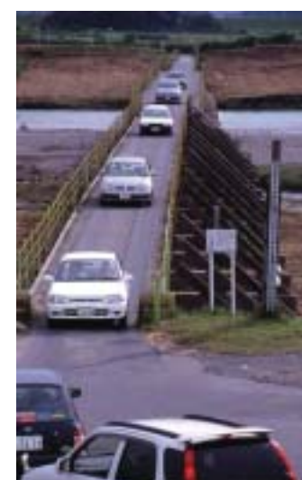
車が譲り合って通行した旧久下橋
