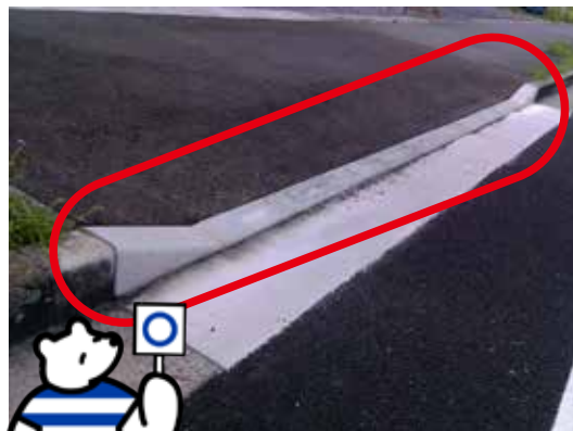
切下げ工事後
