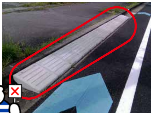
禁止されている段差解消ブロックの例
