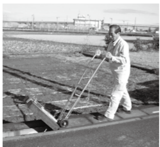
側溝蓋上げ機を使用した様子
