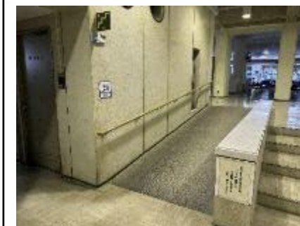
勾配のきついスロープ
