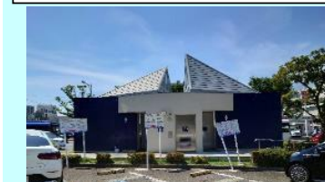
熊谷駅南口駅前広場公衆用トイレ 障害者誘導施設整備事業
