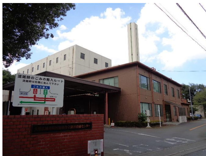
大里広域市町村圏組合立深谷清掃センター
