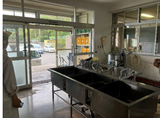
建物を改修し荷受室を設置
