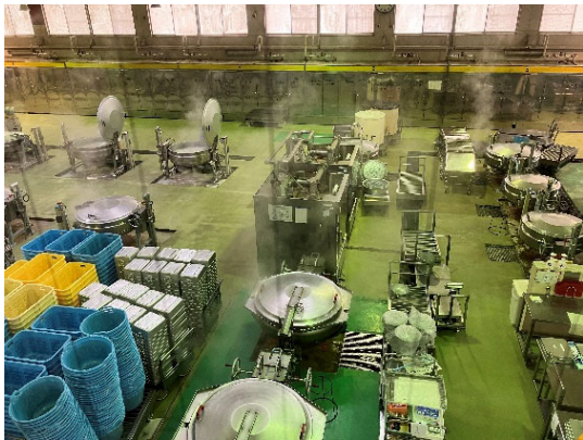
調理室（一部で雨漏りあり）
