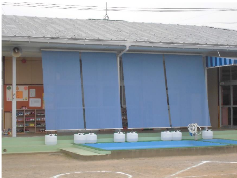
玉井保育所に設置した外付け日よけ
