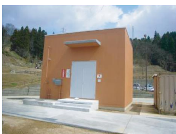
非常用発電装置
