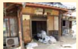
建物の被害状況調査
