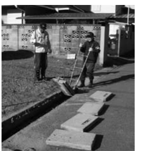
側溝蓋上げ機を使用しての側溝清掃
