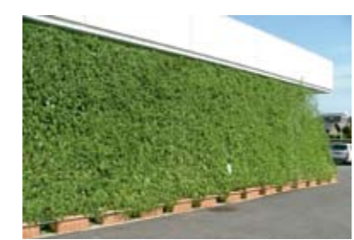
妻沼行政センターの壁面緑化
