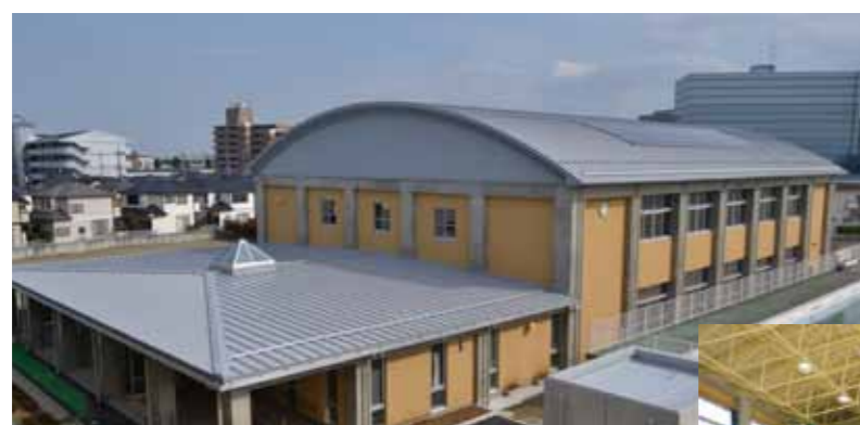
改築された太陽光のある体育館外観
