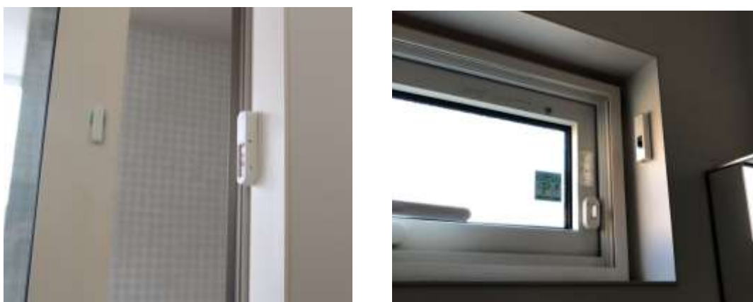
図 8-2-2 開閉センサー（左）、温湿度センサー（右）
