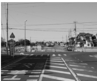
第2北大通線道路改良事業
