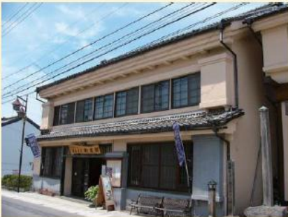
まちづくり推進協議会が管理・運営している 観光・交流拠点であるほんまち町屋館
