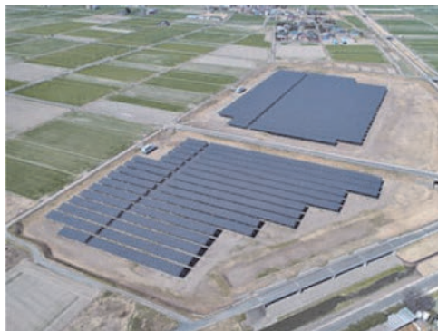
調節池を利用したメガソーラー
