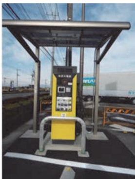
急速充電設備
