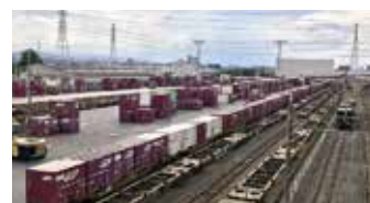
熊谷貨物ターミナル駅 コンテナホーム
