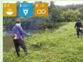
ため池堤体の草刈り
