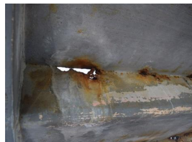
腐食 鋼材が錆びている状態
